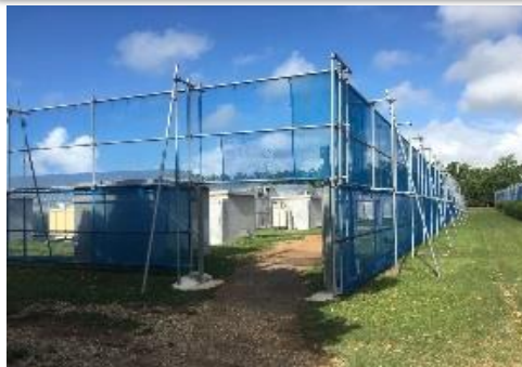
防風ネットの設置
